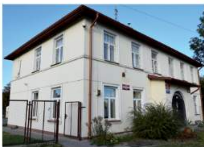
W dawnym budynku Urzędu Gminy w Mircu obecnie mieści się biblioteka publiczna. (Fot. UG Mirzec)
